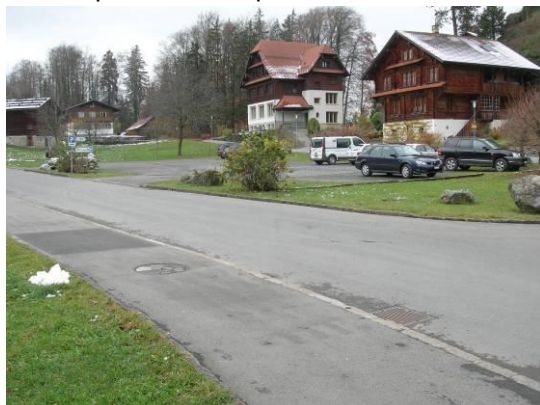
Zone de stationnement dépourvue de tout marquage au sol
